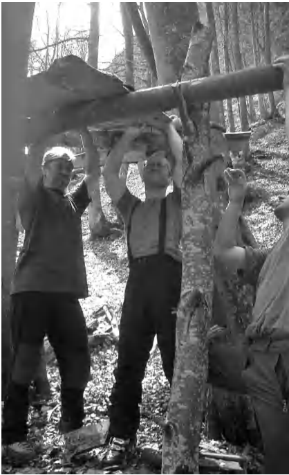
Neubau des Holzdepots, Mai 2010
